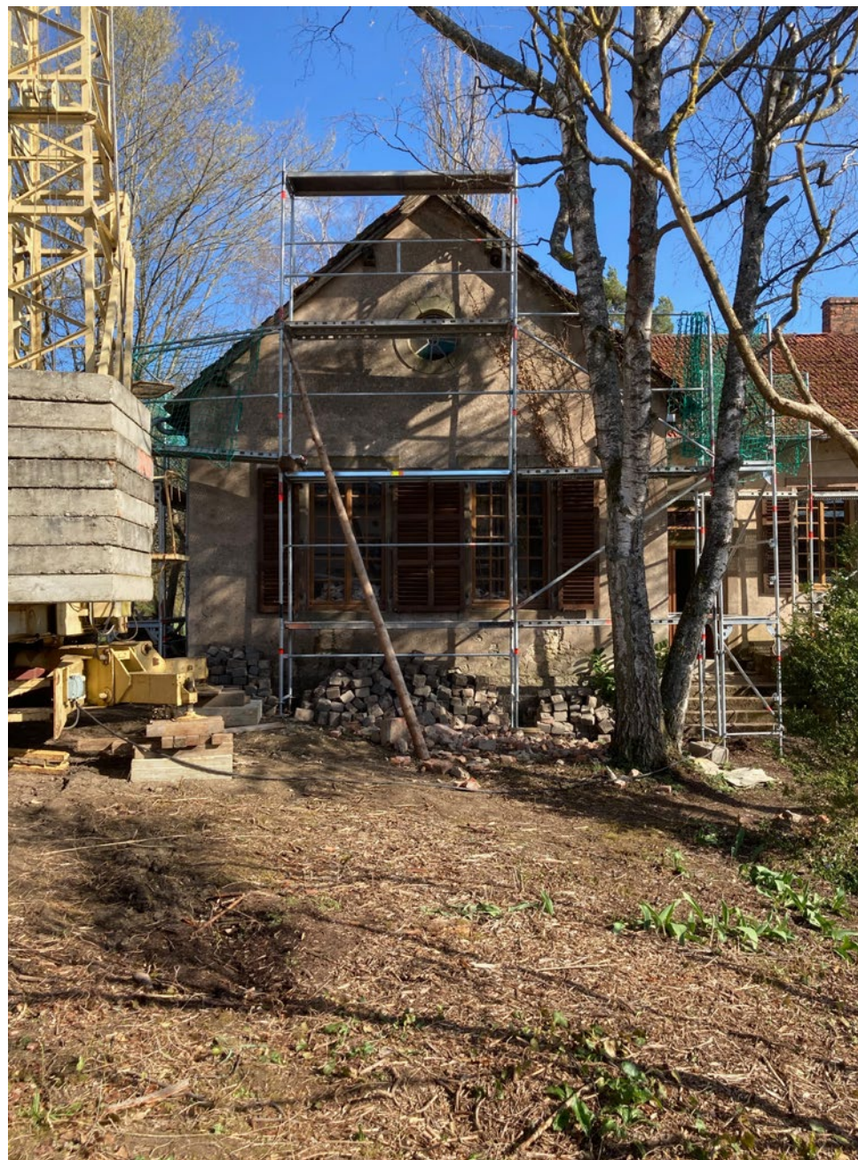
Das ehemalige Schulhaus in Remeldorff gleich hinter der Grenze zu Frankreich bauen die Architekten für den Eigenbedarf um. Fotos: Huffer Wenzel
